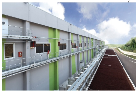
(2) BIOFILTRO PER ABBATTERE GLI ODORI DEL PROCESSO
